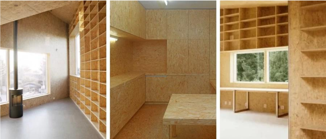
OSB板の施工例
